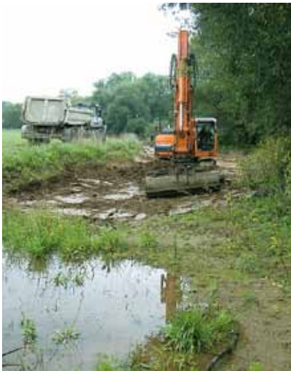
Baggerarbeiten im Abschnitt I
